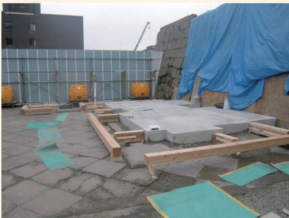
礎石の位置と高さを明確にするため、礎石の周りに木材(角材)の定規を据え付け、その定規に柱芯の位置と礎石の高さの印を付けます。
