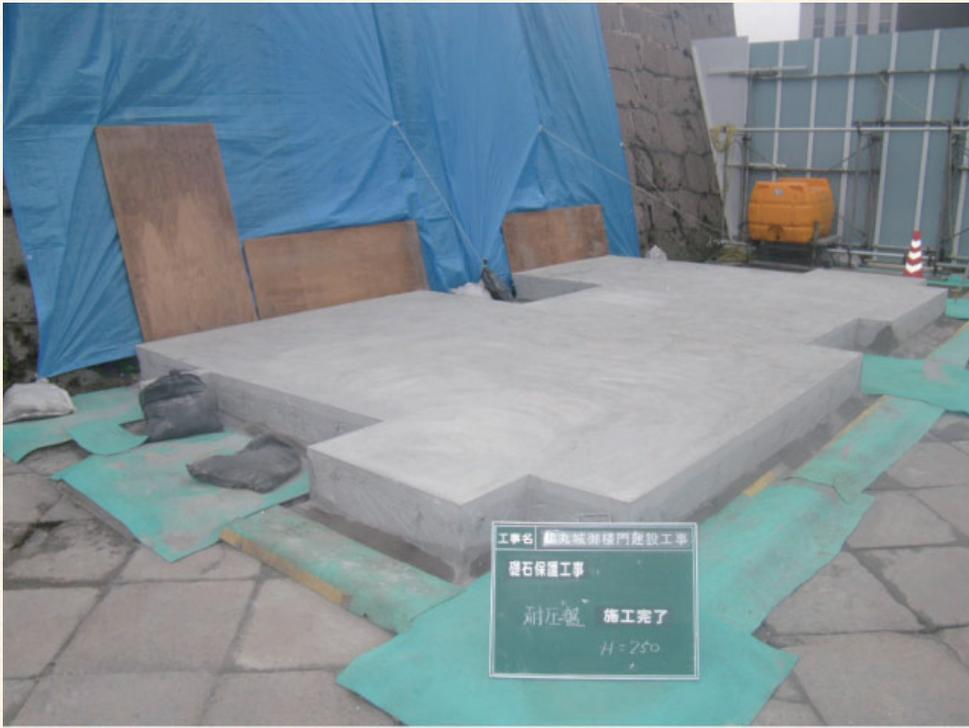
養生後、型枠を外すと、鉄筋コンクリートの耐圧盤が完成しました。
