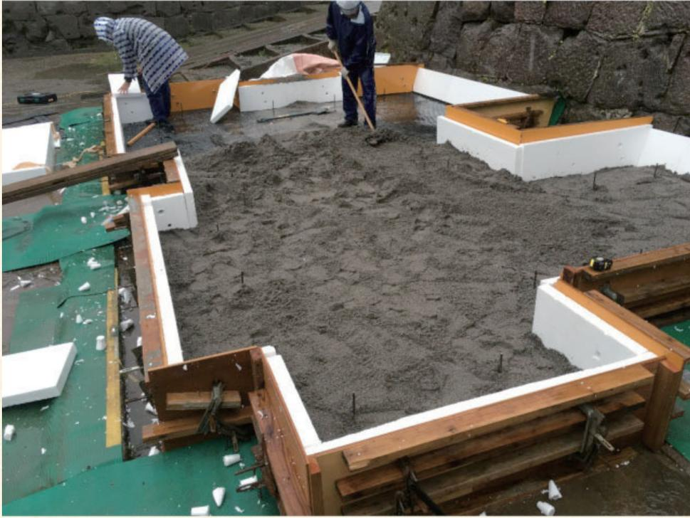
敷いたマットの上に養生砂を敷き詰め、突き固めます。
