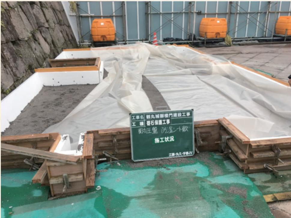
養生砂を突き固めたら下から湿気が上がって来ない様に、又コンクリートが型枠の隙間から流れだして礎石を汚さない様に、防湿シートを敷き込みます。
