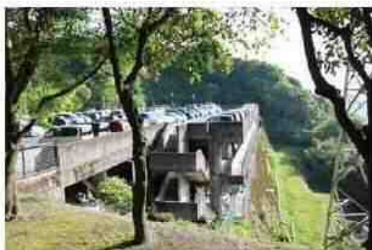
写真-4 観光ホテル立体駐車場
