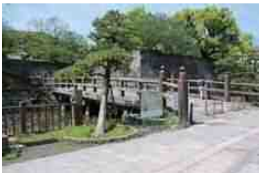
写真-10 御楼側出入口 (石橋)
