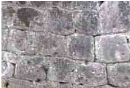
写真-7 亀甲 (崩し) 積み
