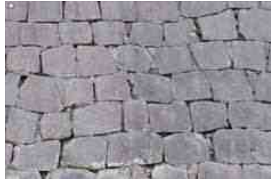
写真-6 粗加工石積み (粗加工石材の布積み①)
