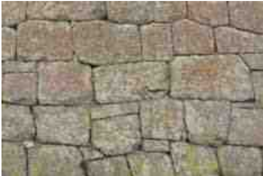
写真-5 切石積み (精加工石材の布積み②)
