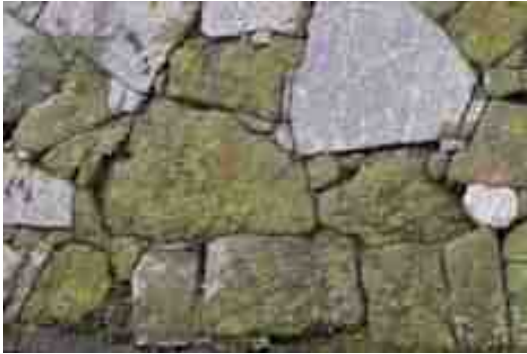
写真-3 野面積み (割石の乱積み)
