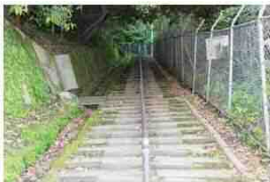
写真-7 自然石の階段と側溝
