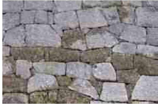
写真-4 割石積み (粗加工石材の布積み②)
