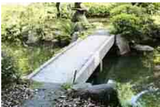
写真-12 御庭の石橋 (九臯橋)
