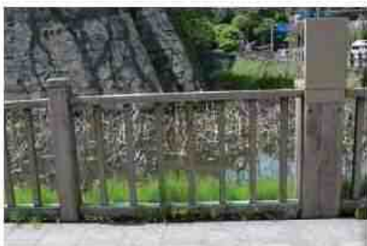
写真-19 堀周辺の柵
