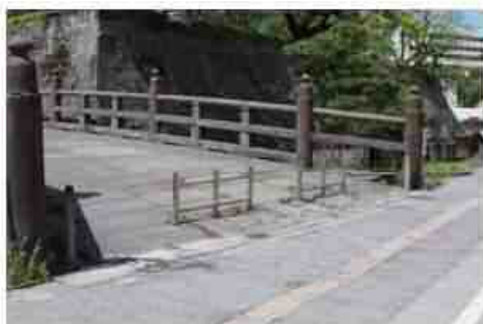
写真-20 橋上の車止め
