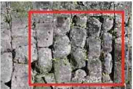
写真-4 火災時の熱で角がとれ丸くなっている
