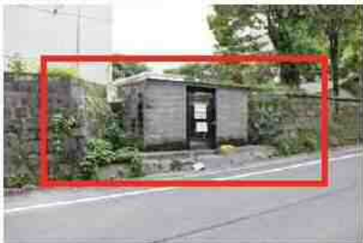
写真-19 ゴミ置き場設置による積み替え
