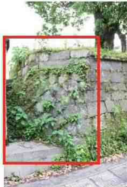
写真-20 積み替え部拡大
