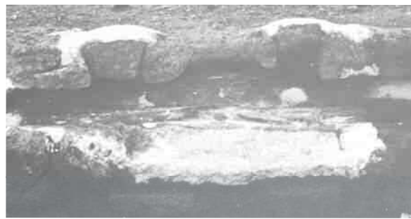
上水道石管断面
