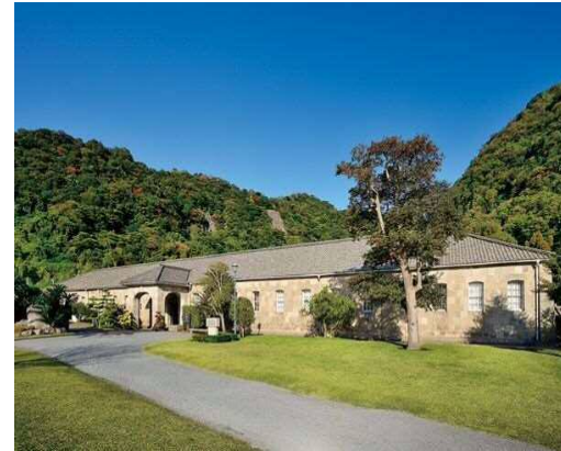
旧集成館機械工場
