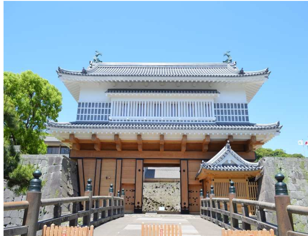
御楼門完成写真
