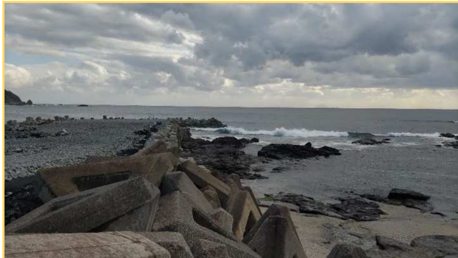
(監査人撮影：離岸堤への仮道)
