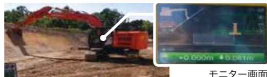
ICT対応重機での施工補助員がいなくても、モニター画面で整形を進めることができる
