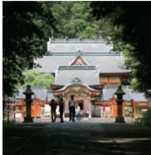
現在の社殿は江戸中期、正徳5(1715)年、第21代藩主島津吉貴公により造営寄進されたもの。平成元年に本殿・幣殿・拝殿・登廊下・勅使殿などが国の重要文化財に指定されています。
