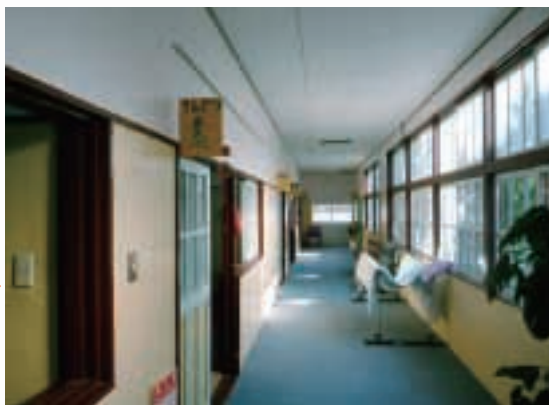
▲昔の中学校の雰囲気が残る施設内。段差をなくすため80m余りの廊下をかさ上げしました。
