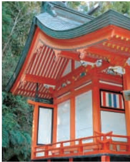
本殿は県指定有形文化財。
